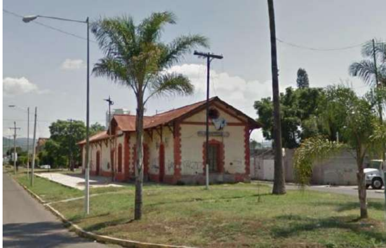
Figura 38. Ex-estación ferroviaria. Fuente: archivo fotográfico.
